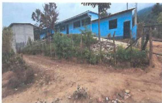
Foto 1: Mejoramiento de cerramiento perimetral del centro educativo
